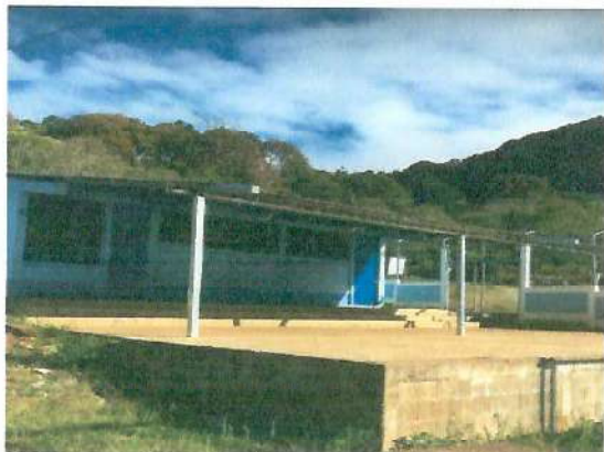
Foto 1: Cubierta de lamina calibre 26 troquelada y estructura metalica tipo portico.
