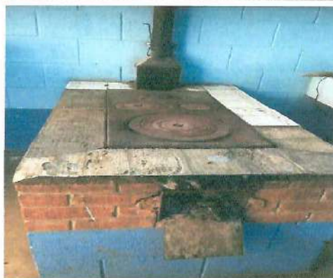
Foto 3: Reparación de cocina, polleton y asulejo en mesa de concreto.
